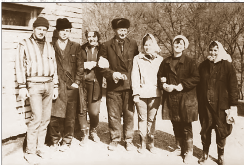
Волонтеры-строители на крыше первого корпуса Института. Слева направо: инж. Ю. Шульга, студент Ю. Абрамов, зав. лаб. О.Е. Преснякова, зав. лаб. М.А. Михайлов, асп. Л. Стаценко, О.Н. Лифшиц, лаб. Т.И. Ведерникова. 1970 г.
