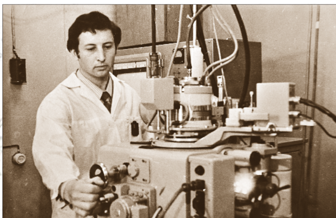
Ст. инж. М.Ф. Эйберман проводит испытания первой высокотемпературной камеры для РСА. 1976 г.
